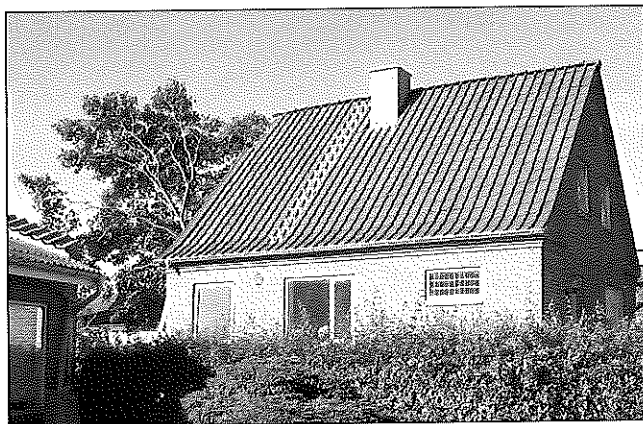
Elmevej 24 har efter ejerskifte fået nyt tag
