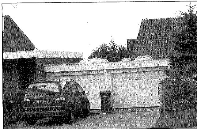
Bålhøj 7 har fået udskiftet enkelt-carporten med en dobbeltgarage inkl. fjernbetjent port - og garagen er så stor, at den kan bruges til gadefester.
