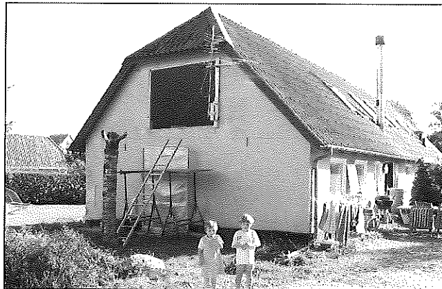
På Overgaard - Kappelvej 7 - er familien i gang med en rask omgang overalt - ude og inde samt oppe og nede! Familien og deres mange børn bor rundt om i huset alt efter, hvor der arbejdes - ikke efter hvor noget bliver færdigt - endnu.
