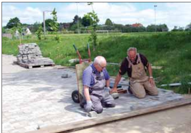
Bjarne og Kaj fra håndværkrådet i gang med fliselægning
